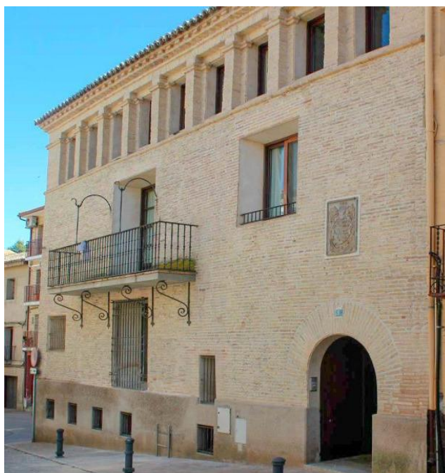
Edificio Casa del General Ortega, sede de ADRAE
